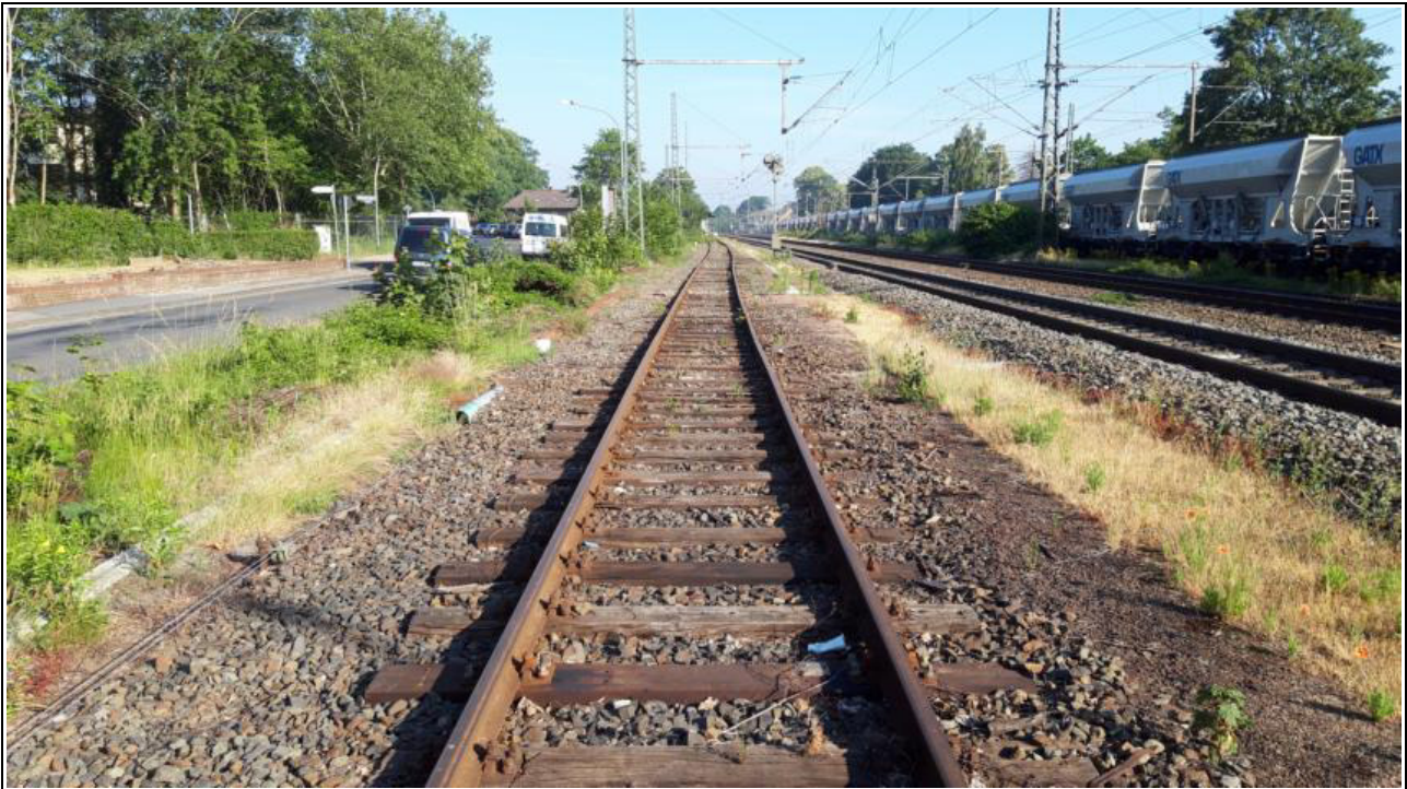
Bild 1: Gleis 7, Bahnhof Meppen
